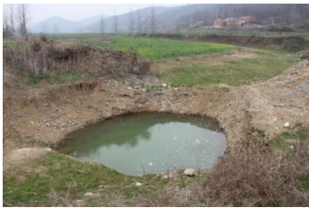
图 2 峡卡河水库尾坝附近地面塌陷
