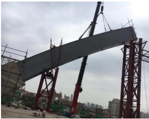
图 4 拱肋安装现场图
