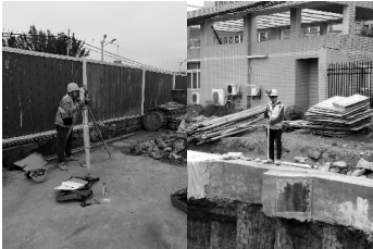
图 4 围护墙(边坡)水平位移监测
